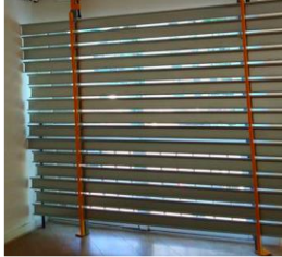
Exemple protection sur deux étais <6m 2
